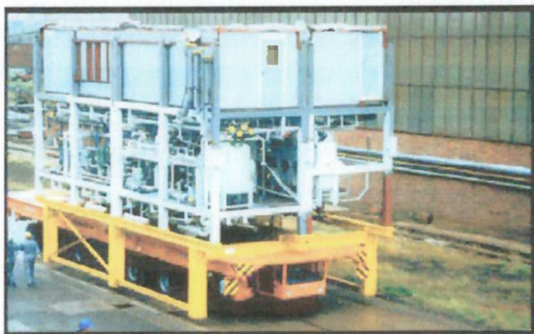
Figura 7.7: Colocação modular de equipamentos na casa de máquinas.
