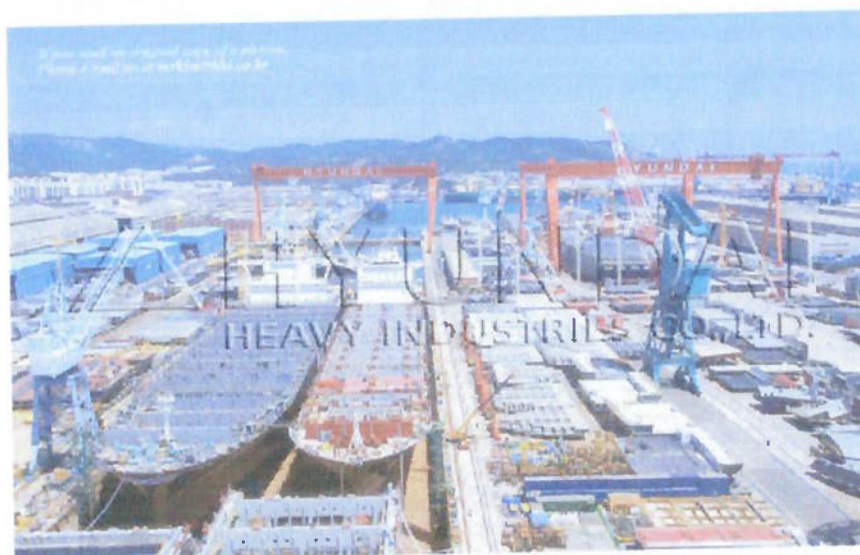
Figura 6.4: Foto do dique 3 do Hyundai que pode construir vários tipos de navio em paralelo.
